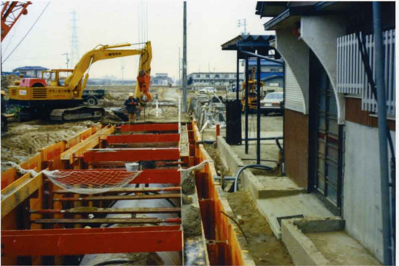
▲民家接近状況 長尺管敷設の為の腹起し設置（解説：P12,13）
