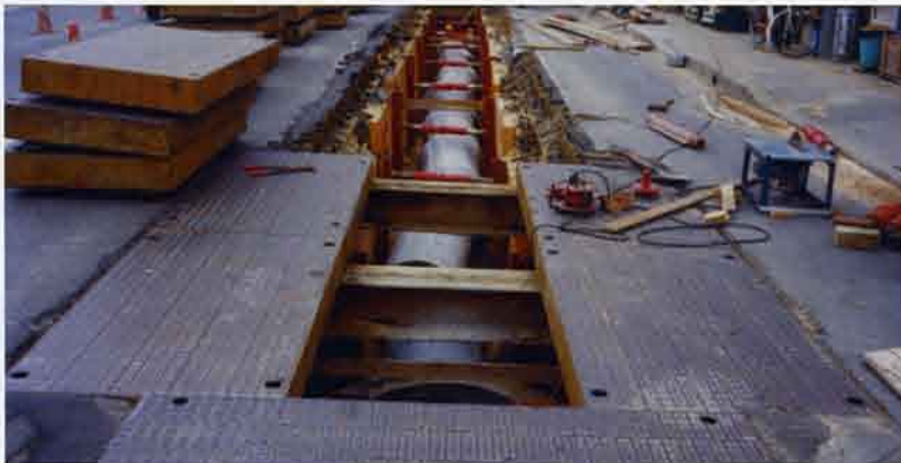
▲覆工板使用による設置（解説：P20）
