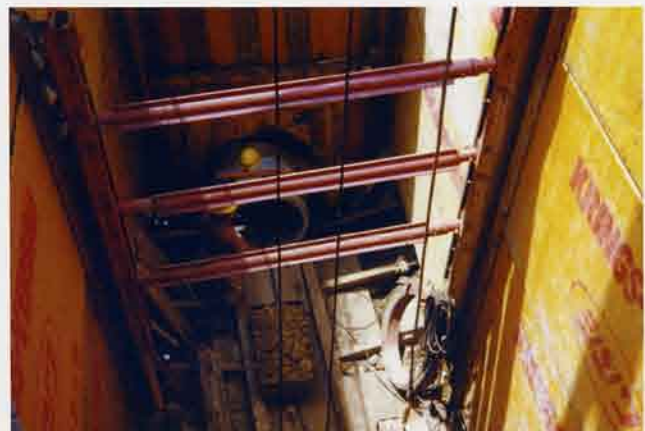
▲推進工事の竖孔
