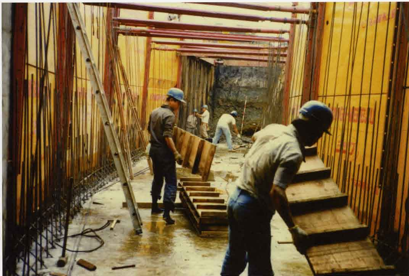
▲ボックスカルバート敷設・曲線対応
