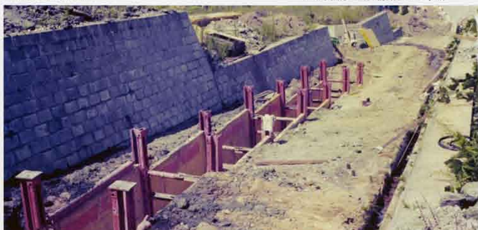
▲傾斜地における階段状土留め
