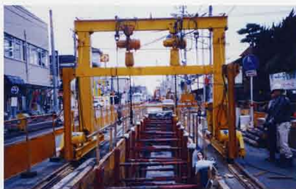
▲専用引抜機設置
